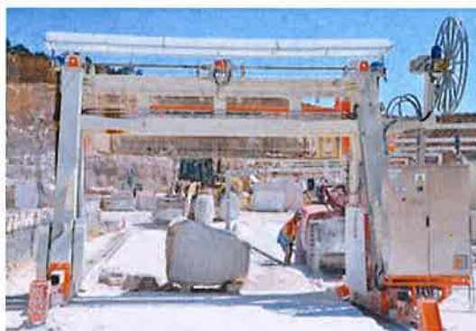
Recoupe de blocs à la haveuse et équarrissage à la guillotine.
